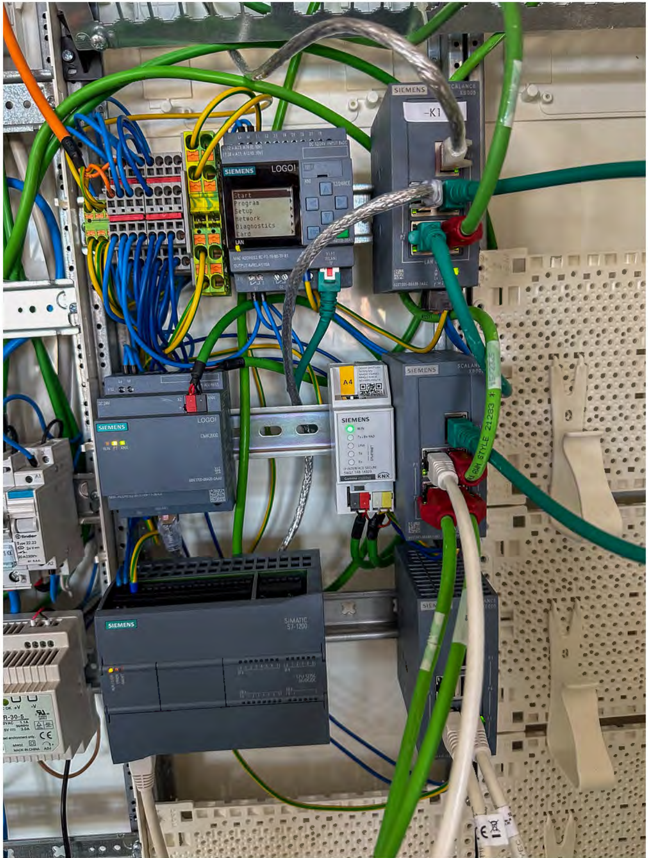
Abbildung 5.22: Einbau Switches
